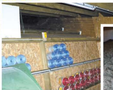
gaine de concentration de chaleur
