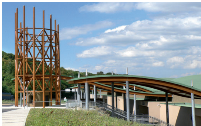
Vue générale du bâtiment
