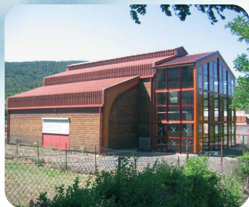
Chaufferie bois - Langeac (43)
