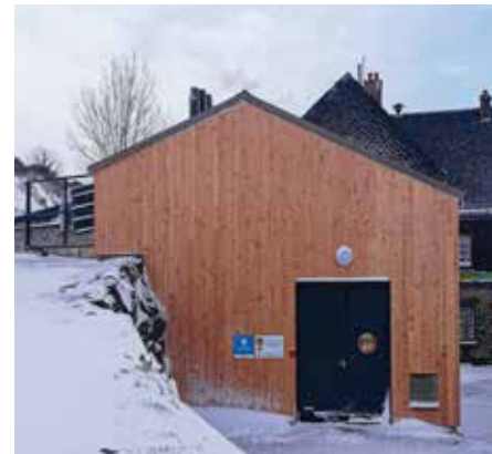
Chaufferie bois BETA Energie
